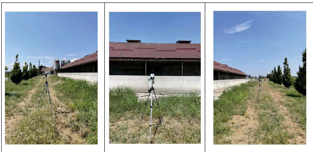
Vista della zona di misura
